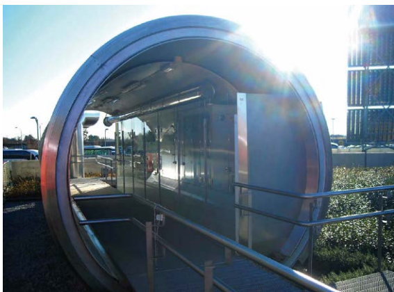
Fig. 1. Sistema de producción de hidrógeno mediante electrólisis, integrado con una pila de combustible polimérica, en el Campus Palmas Altas (CPA).
