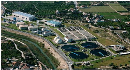
Fig. 1. Vista aérea de la EDAR Murcia Este.
