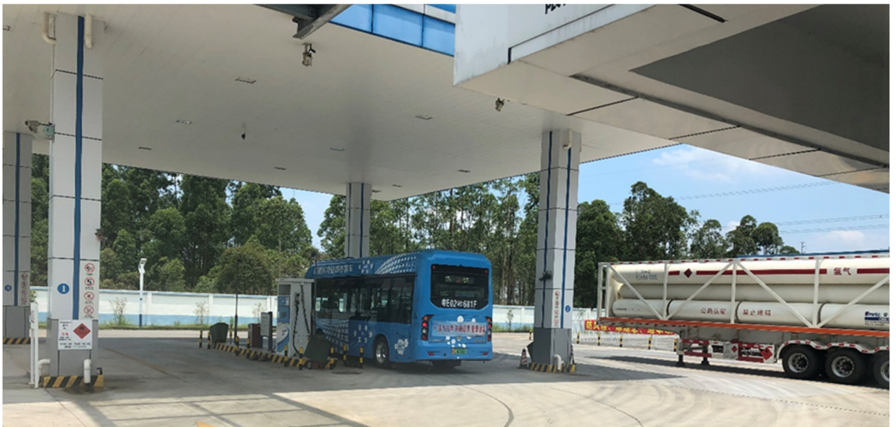
Fig. 1. Estación de servicio de hidrógeno de Rui Hui
